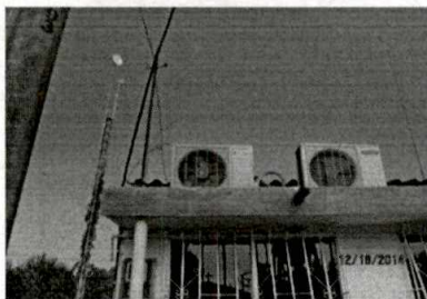
5 DE 18 DETALLE CONDENSADORAS AIRES ACONDICIONADOS TIPO MINISPLIT, SERIA MUY CONVENIENTE PODERLOS UBICAR EN UN MISMO LUGAR
