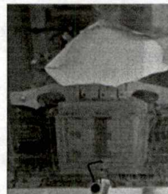
2 DE 18 PROTECCION PRINCIPAL ACOMETIDA, TIPO TORNILLO A TORNILLO DE 3X70 AMPERIOS
